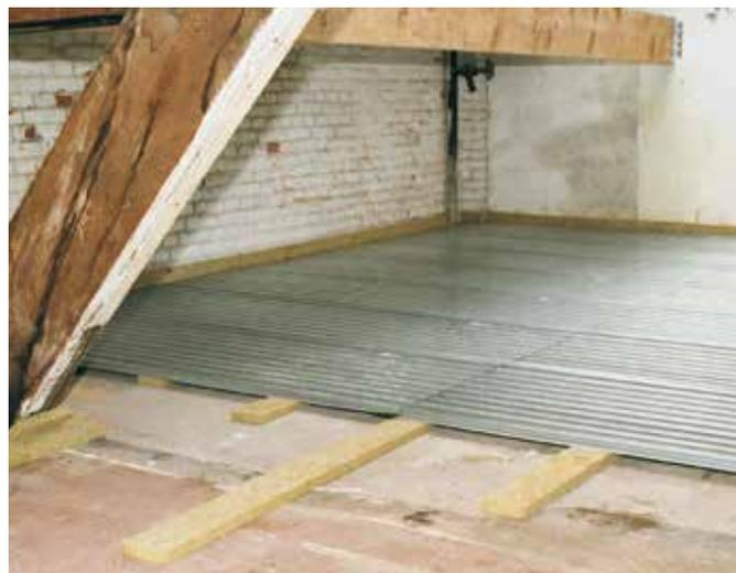
Mise en place des bandes résilientes (laine minérale ou produit équivalent) pour un plancher béton sur profilés LEWIS® flottant et insonorisé
