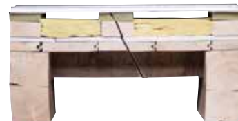
Plancher béton surélevé sur plancher bois
